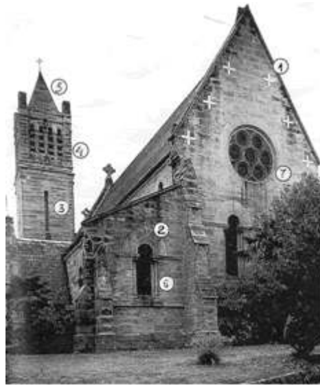
Церковь Св.Иоанна, Глиб.
